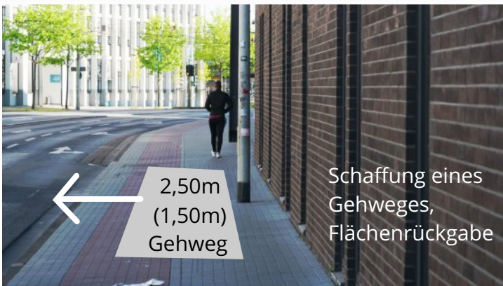
Binger Straße Südseite vor Hotelneubau, Ri Hauptbahnhof
