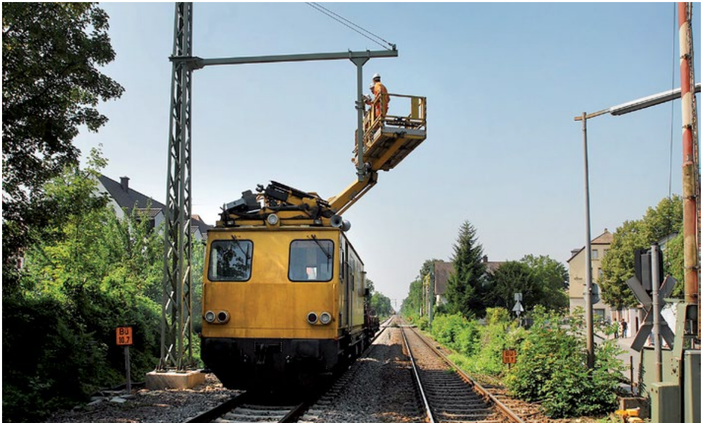
Bild 4: Elektrifizierung der Strecke Schifferstadt – Wörth (Foto: www.foto-lenz.de )
